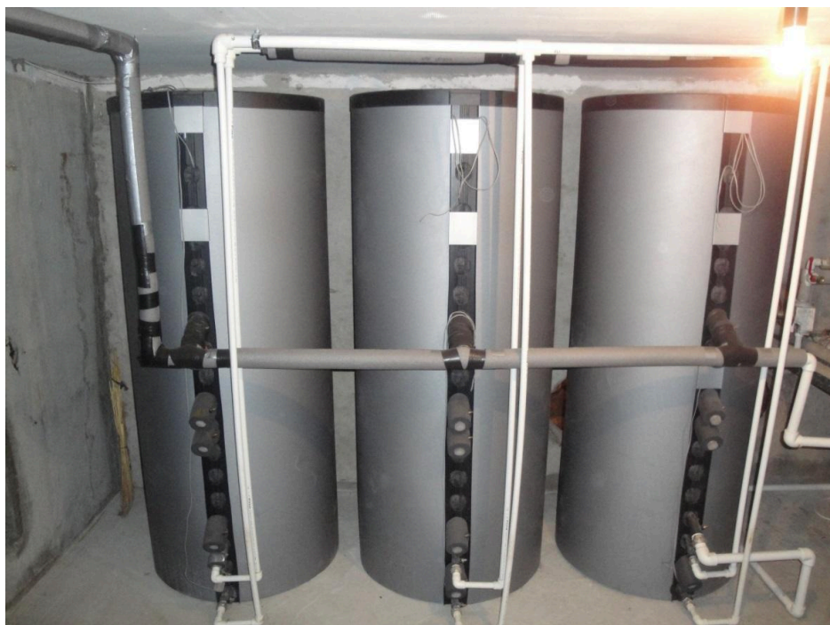
Баки-аккумуляторы тепла
