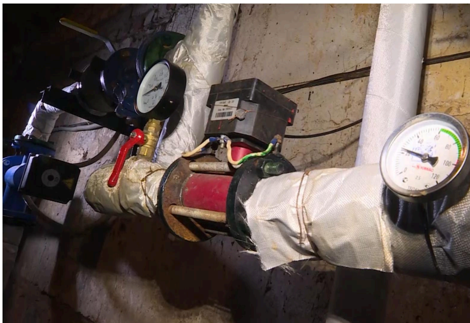
Система контроля подачи теплоносителя
